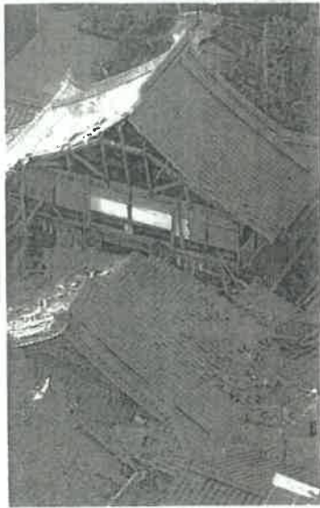
地震で建物の半分が倒れ落ち、内部がむき出しになった上落時 の鳥取県西部地震の被災地。鳥取県西部地震で、本報へりから
